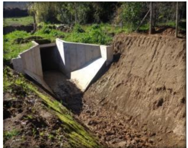
Cámara de salida de Sifón Fortaleza.
