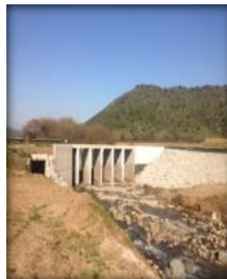
Bocatoma Canal Norte Unificado, barrera frontal.
