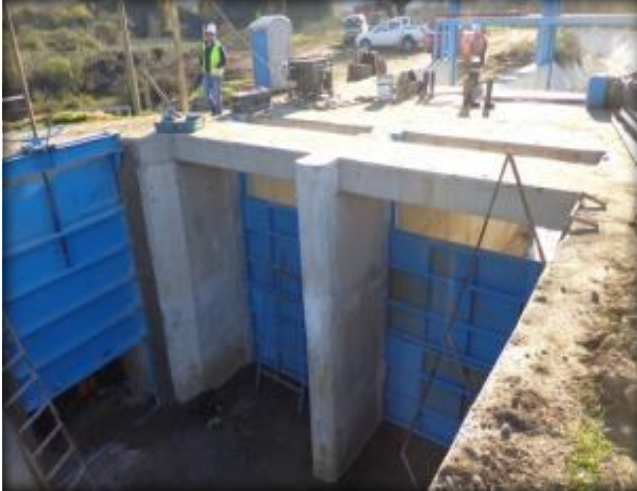
Bocatoma, compuertas de canal de descarga y alimentación.
